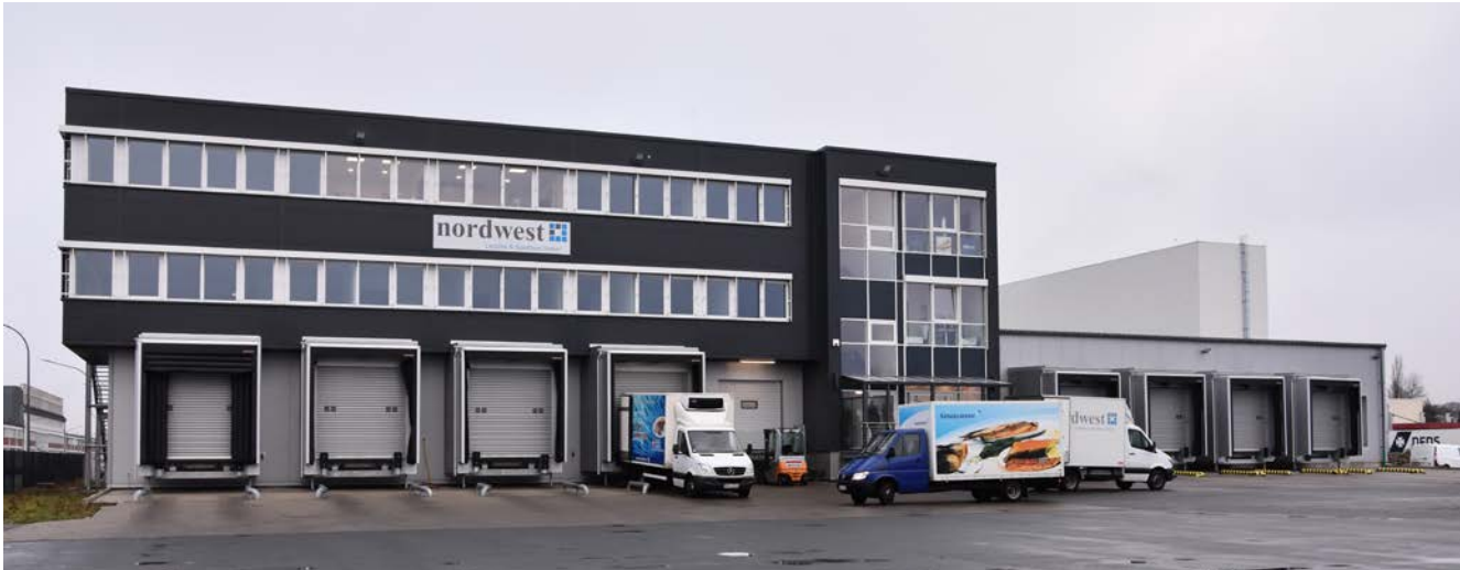
Links neben dem bisherigen Umschlaggebäude schließt sich nun ein dreigeschossiger Bau mit vier weiteren Laderampen an. Neue Bürofläche nutzt teils die Nordwest Logistik, doch mehrheitlich sind die Räume an Kunden vermietet.
