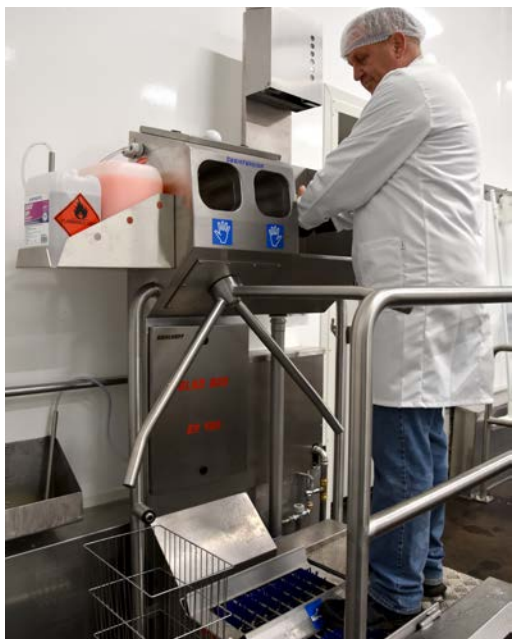
Eine Hygieneschleuse im Eingangsbereich der Umschlagfläche für die Reinigung von Händen und Schuhen ist ebenfalls neu.
